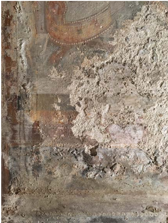
Figura 3 - 4 Cadute di colore, efflorescenze saline e sbiancamenti
