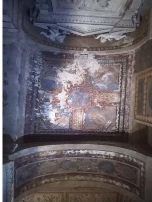
Figura 6 Visione della volta e archi
